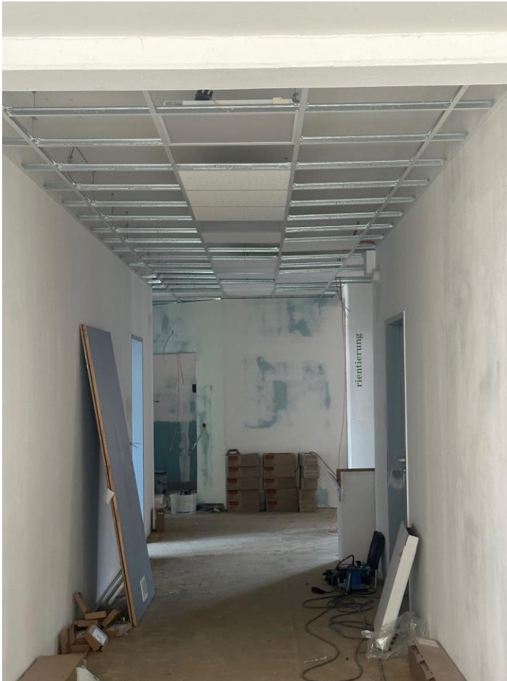
Energetische Sanierung der Decken und Beleuchtung
