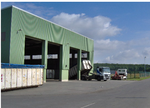
Abb. 4: Umschlaganlage der AEA Camitz
