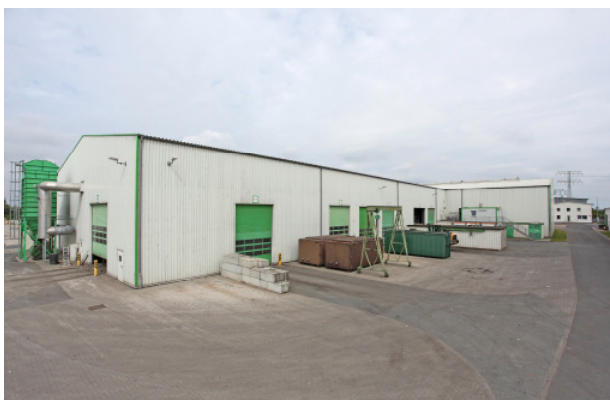
Abb. 8: Mechanische Aufbereitungsanlage Stralsund
