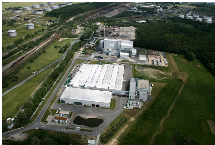
Abb. 6: Luftbild der MBA Rostock einschließlich Blockheizkraftwerk
