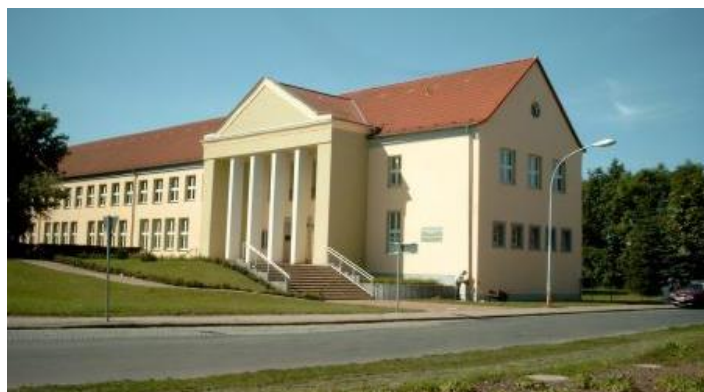
Abbildung 6: Sonderpädagogisches Förderzentrum Grimm
