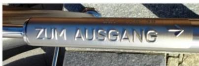
taktilen Schildern in Frage kommen. Dass die gesamte Anlage (kombinierter Wartebereich) auf mind. 20 cm über Fahrbahnniveau angehoben ist, Niveauleichungen und Gefälle unter 3 % bzw. ggf. 6 % gehalten sind, die hohen Kontrastwerte für Sondersteine
